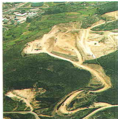
Planta de reciclaje, biometanización y compostaje de A. Coruña. (En construcción)
