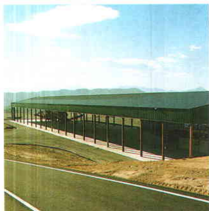
Planta de compostaje de Lorca.
